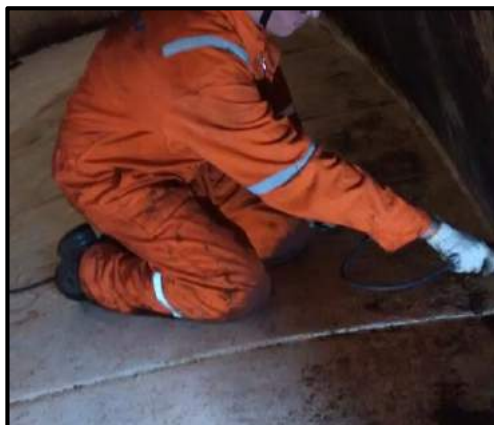
Ensaio de ACFM na solda de ligação costado e fundo
